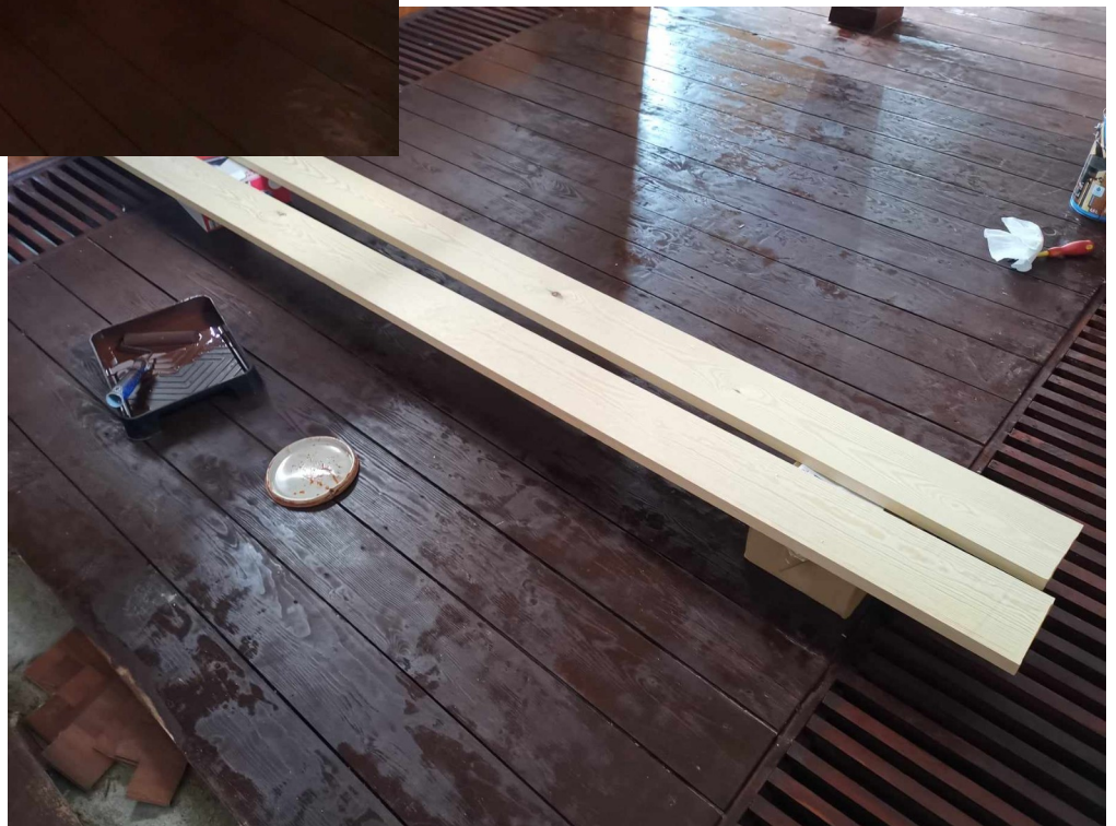
Montaż nowej półki na eksponaty oraz wymiana desek podłogowych
